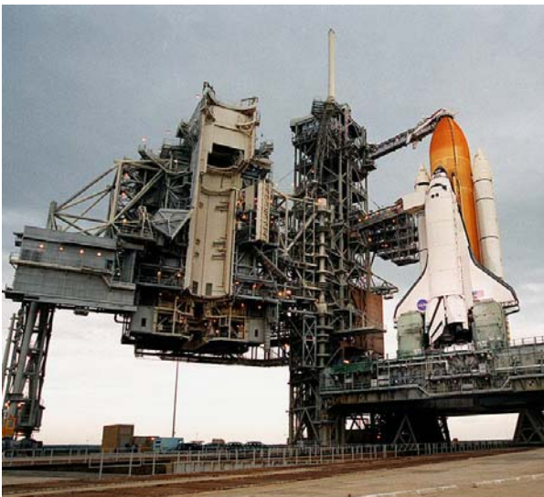
Shuttle Discovery auf dem Startplatz am 16. Dezember 1999 vor dem Start zur STS-103 Hubble Weltraumteleskop-Wartungsmission mit den ESA-Astronauten Claude Nicollier und Jean-Francois Clervoy. Die drehbare Wartungsstruktur (links) ist zurückgefahren. (Foto: NASA)
