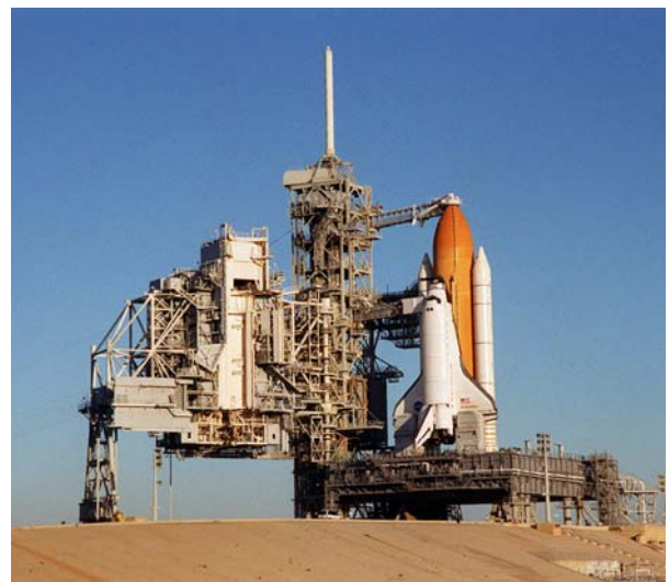
Die drehbare Wartungsstruktur in ihrer Parkposition vor dem Start der Mission STS-97. (Foto: NASA)
